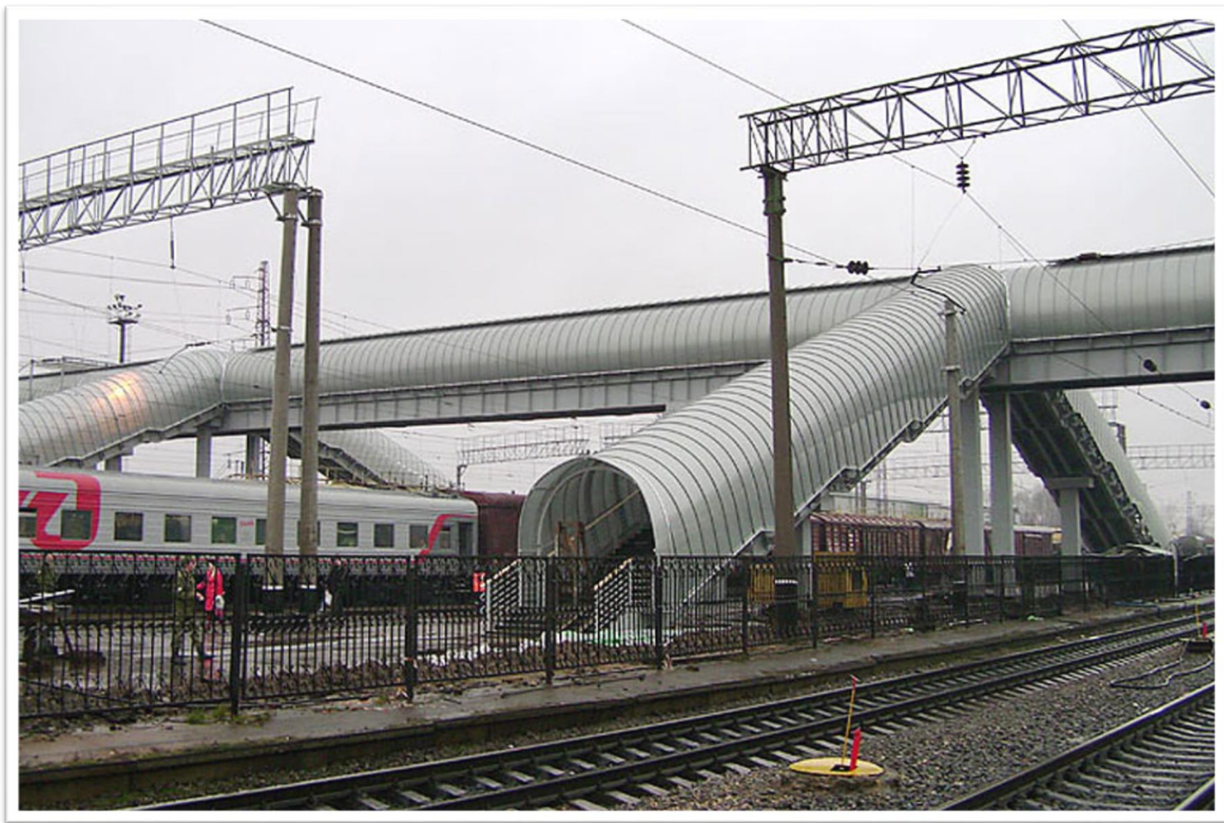
Новый пешеходный путепровод, через железнодорожные пути на станции Шарья.
